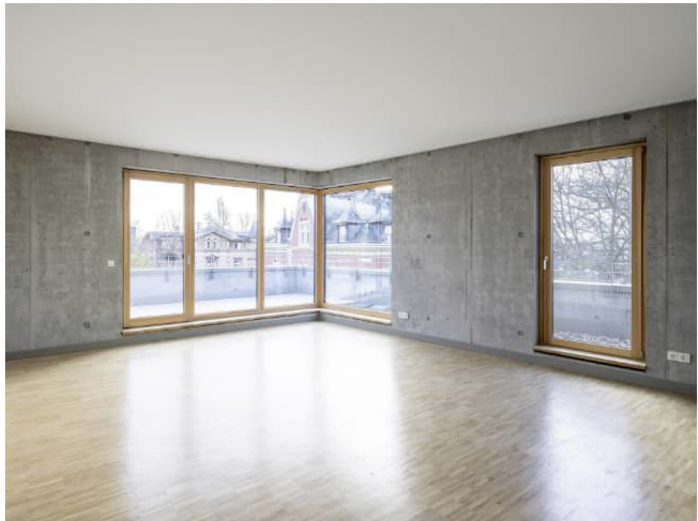
Der Leichtbeton in Sichtbeton-Qualität ist dämmend, mineralisch und zu 100 Prozent recyclebar. © Jörg Hempel Fotografie
