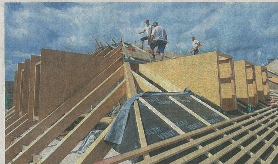
Den Wolken ein Stück näher: Die Dachdecker arbeiten im Moment für den Dachstuhl am „Frieseneck“.
