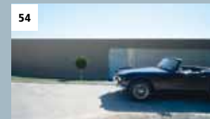
54 HAUS AUF DER ALB C18 Architekten, Stuttgart (D)
