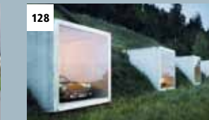
128 TIEFGARAGE UNTER DER WIESE Peter Kunz Architektur, Winterthur (CH)
