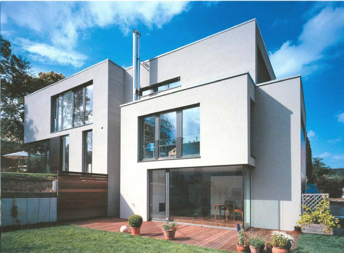
Die Fassade des Doppelhauses erhielt einen feinkörnigen Wand- und Sockelputz. Raumhohe, lackierte Holzfenster werden ergänzt durch teilweise putzbündig eingebaute Schlitzfenster.
