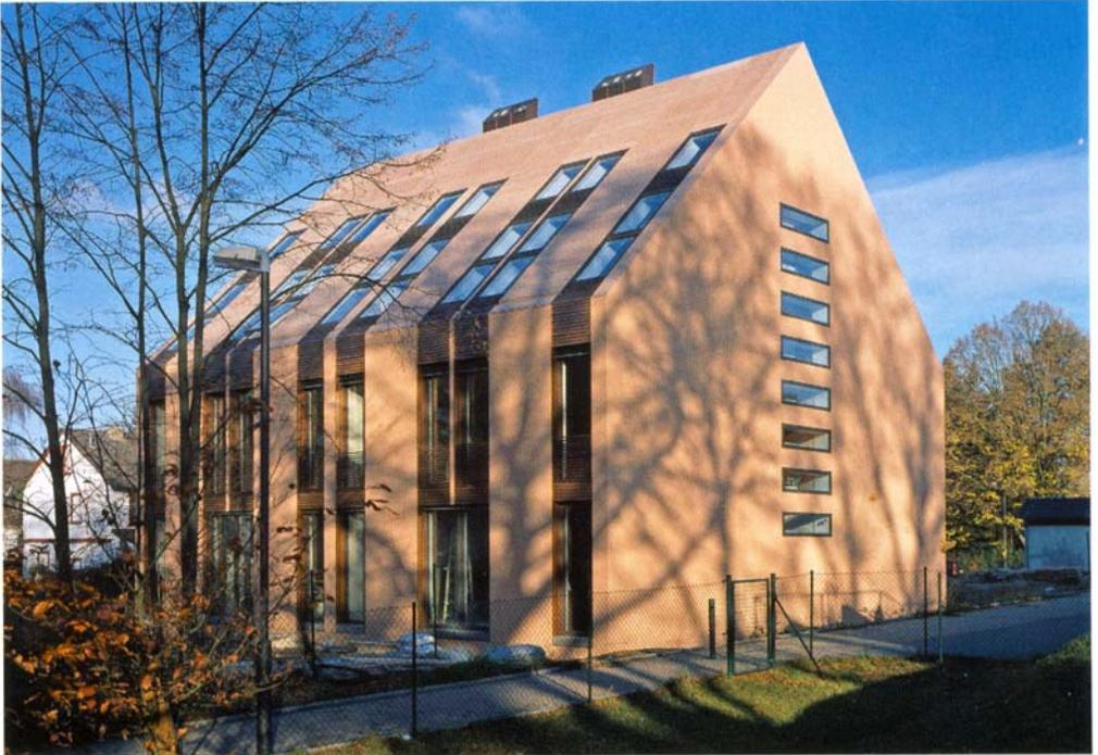
Wie eine zweite Haut liegt die Haushülle um den Baukörper. Da wollen Anschlüsse sorgfältig detailliert sein. Auch die Abstimmung der Innenräume auf die äußerlich rigide Anordnung von Öffnungen will überlegt sein – hinter den horizontalen Fenstern liegt nicht etwa das Haupttreppenhaus
